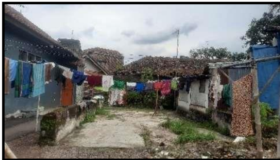
Gambar 4. Rumah Tidak Layak Huni
